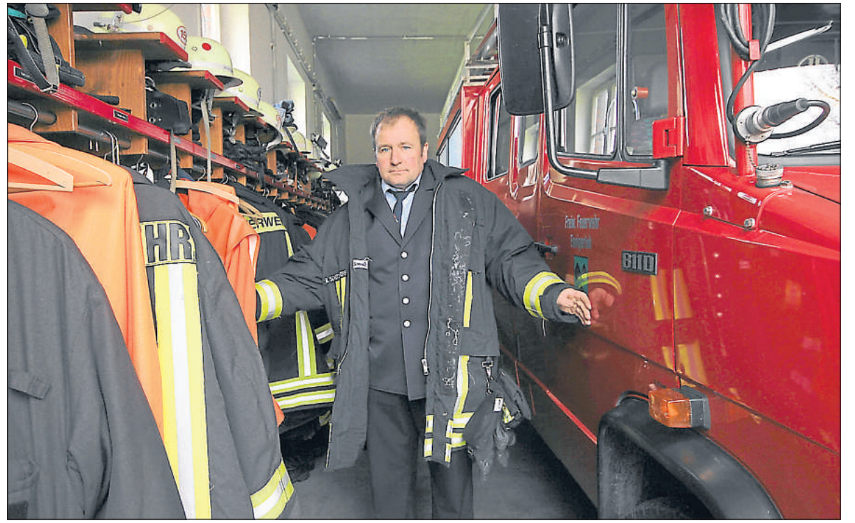
Die Alarmmuckeln befinden sich in den Hallen des Feuerwehrgerätehauses Hoest unmittelbar neben den Fahrzeugen, wie Löschzugführer Hubert Höner zeigt. Diese und weitere Sicherheitsmängel sind der Grund, warum die Stadt Ennigerloh mehrere Millionen Euro in den Umbau beziehungsweise Neubau von Feuerwehrgerätehäusern in diesem und in den nächsten Jahren investieren muss. Archivbild: Rautenstrauch
